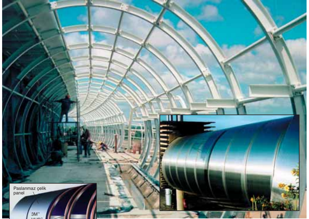
Fortaleza Havaalanı, Fortaleza, Brezilya Mimar: Claudio Silva, 1997 Paslanmaz çelik panellerin çelik çerçevelere birleştirilmesi
