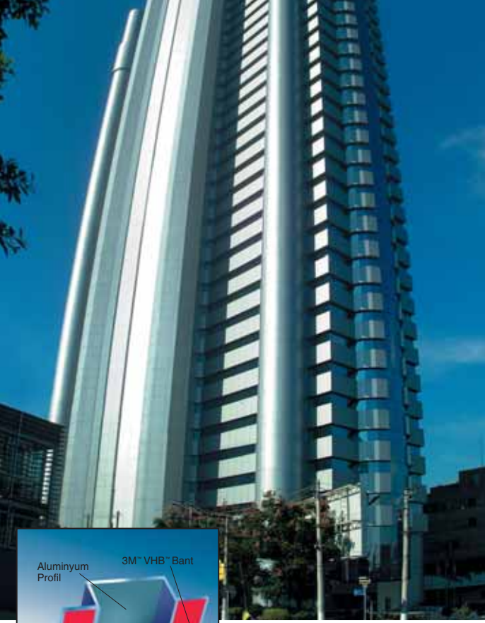
Plaza Centenário, Sao Paulo, Brazil Mimar: Carlos Bratke, 1995 Aluminyum profillerin ACM panellere birleştirilmesi.
