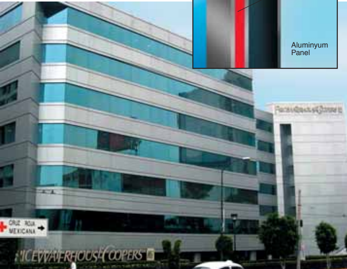
Price Waterhouse, Mexico City, Meksika İnşaat: Salvador Diaz Dupont, 2001 Aluminyum panel – çerçeve birleştirme
