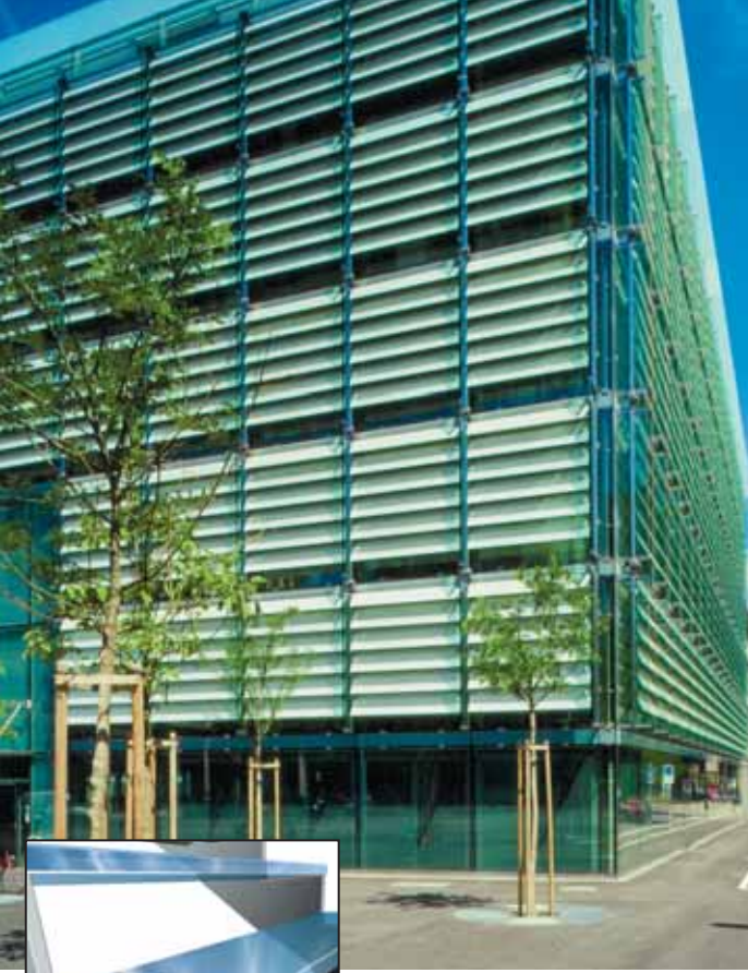
Tamedia Binası, Zurih, İsviçre Çephe tasarımı: Soder AG, 2001 Cam basamakların lake çelik çerçevelere birleştirilmesi
